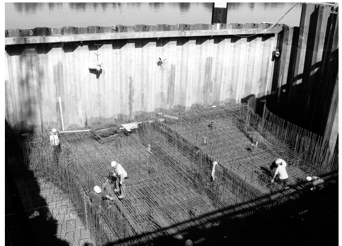
Bewehrungsarbeiten am zentralen Einlassbauwerk
