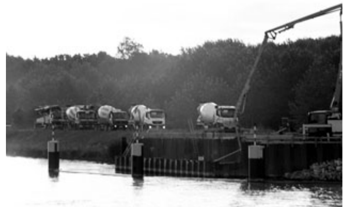
Betonieren der Bodenplatte am 4. Oktober 2016
