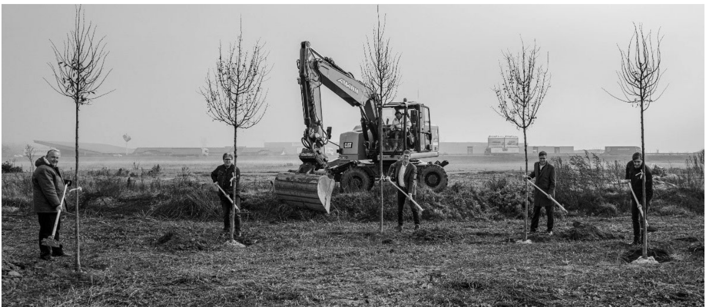
Gemeinsam pflanzen Hauptamtsleiter Daniel Kunz, Achim Hannott (BDF), Bürgermeister Jochen Paleit, Georg Lange (BDF) und Christoph Windscheif (BDF), v.l.n.r., Linden und Feldahorne auf der Baustelle der neuen Fertighauswelt.
