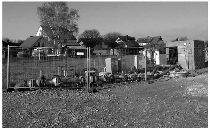
Versuchsbrunnen an der Rittstraße mit Ablaufleitung
