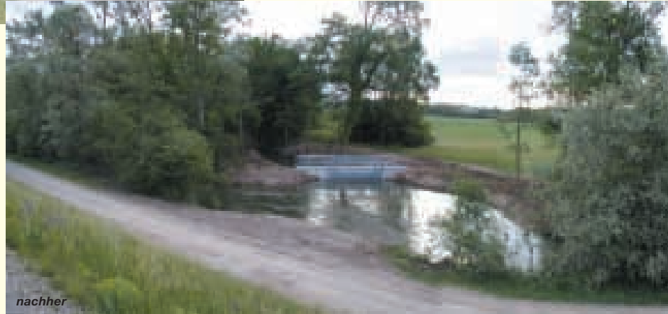
Maßnahme M10: Errichtung von Verbindungsbauwerken
